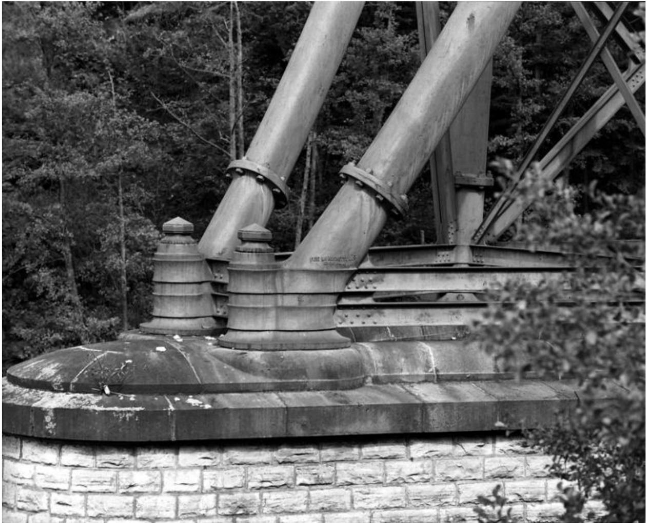
Détail de la base d'une pile métallique sur sa culée en maçonnerie.
