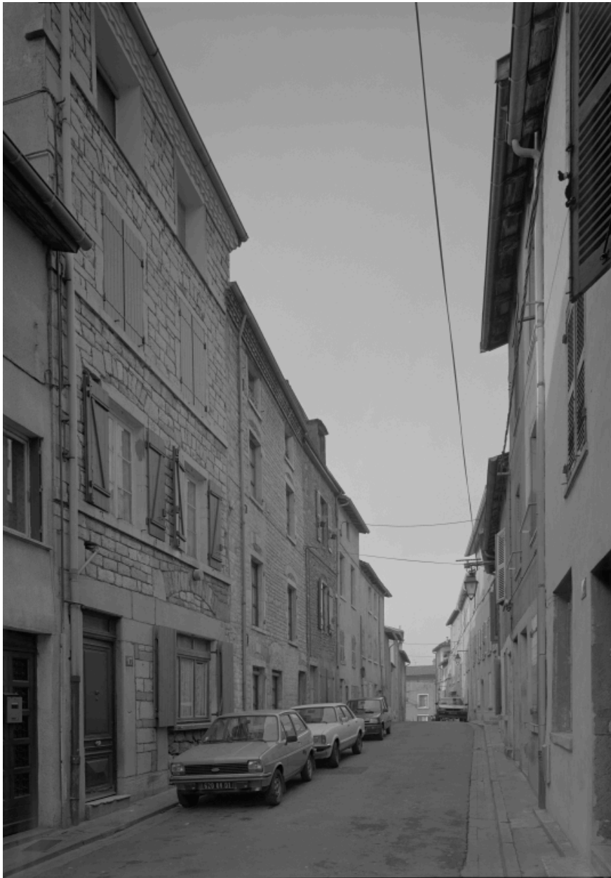
Rue Montsec, alignement n° 17 à 27.
