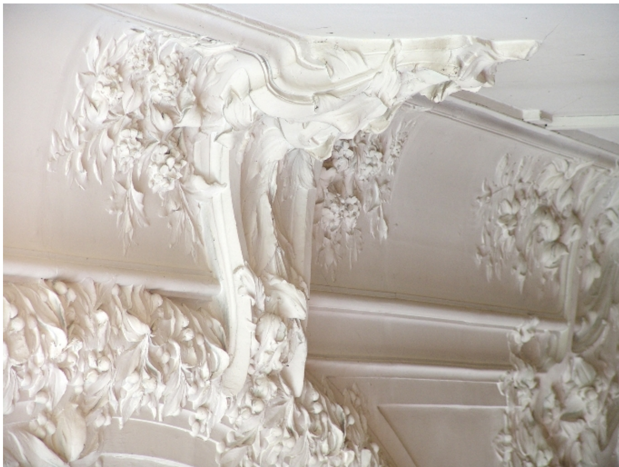
Plafond à décor de stuc, détail
