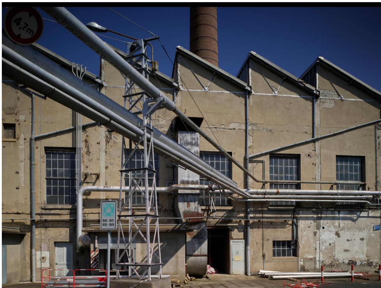
Détail de l'élévation ouest du bâtiment B41 de la chaufferie.
