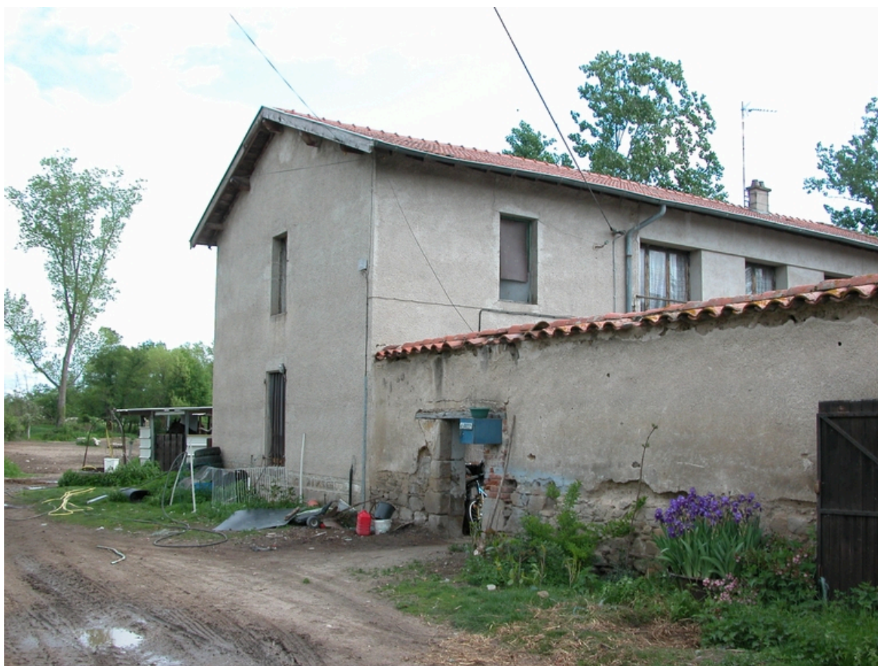
Vue de la partie ouest du logis.
