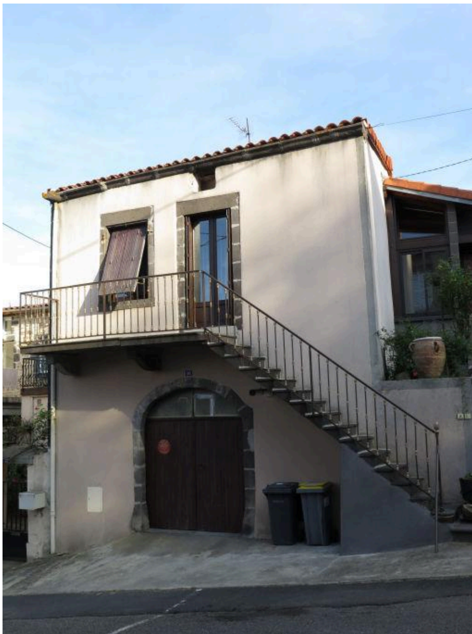
Escalier suspendu et rampe d'appui métallique, parallèle à la façade, et palier surmontant l'accès au cuvage : Ceyrat, 16 rue de la Varenne
