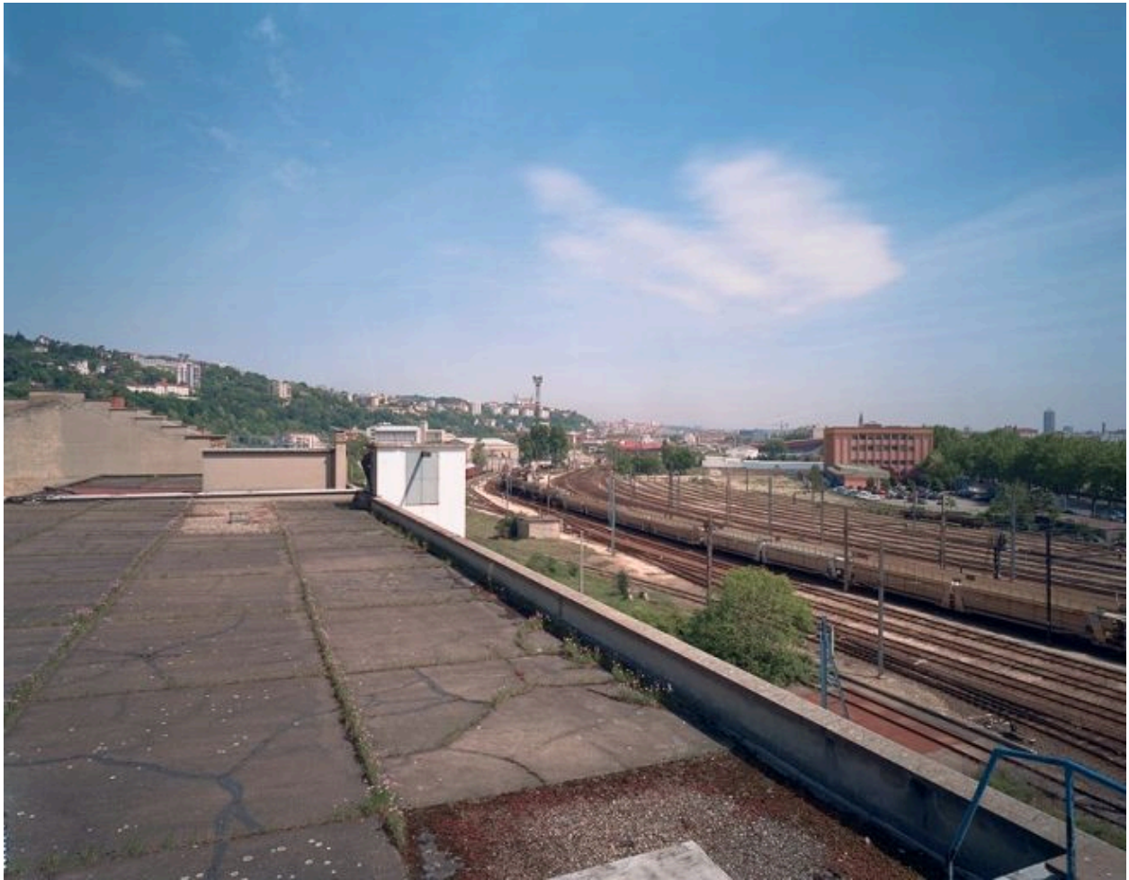
Vue d'ensemble des voies vers le nord, depuis le toit de l'entrepôt des sucres
