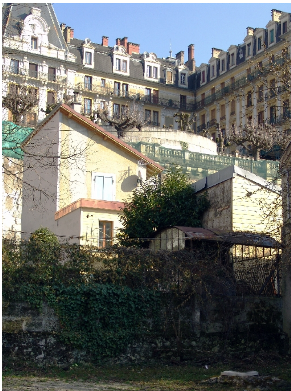
Vue prise de l'ouest
