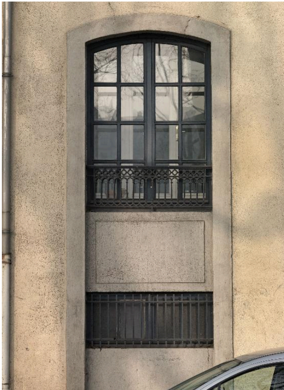
Elévation postérieure, 1er niveau d'élévation, détail d'une baie
