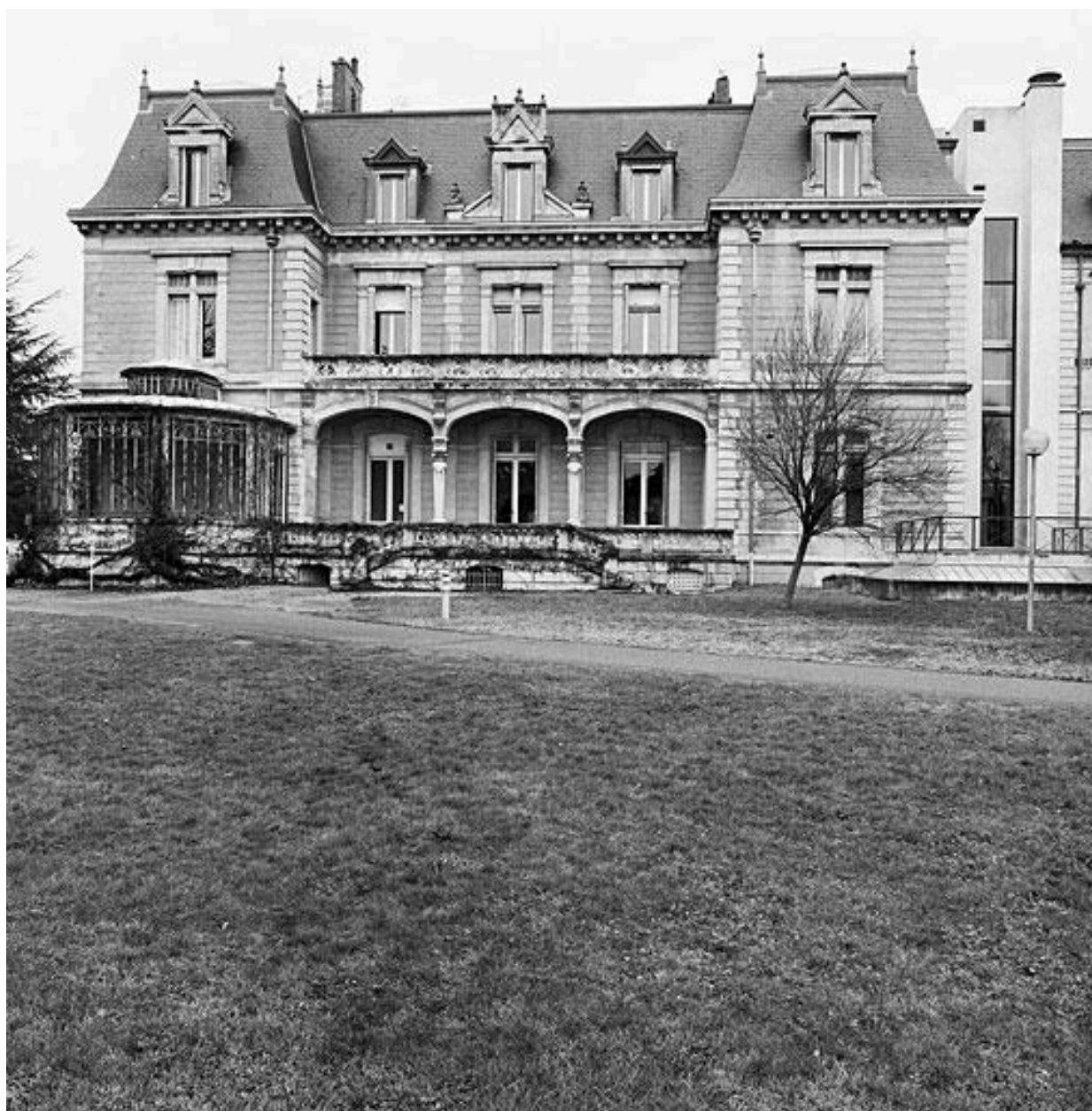
Façade avec galerie côté parc
