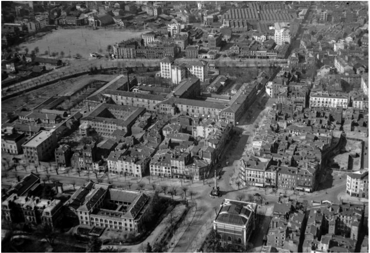
Hôtel-Dieu de Clermont-Ferrand. L'enclos et les bâtiments de l'hôtel-Dieu vus du nord-est, photographie aérienne, vers 1940.
