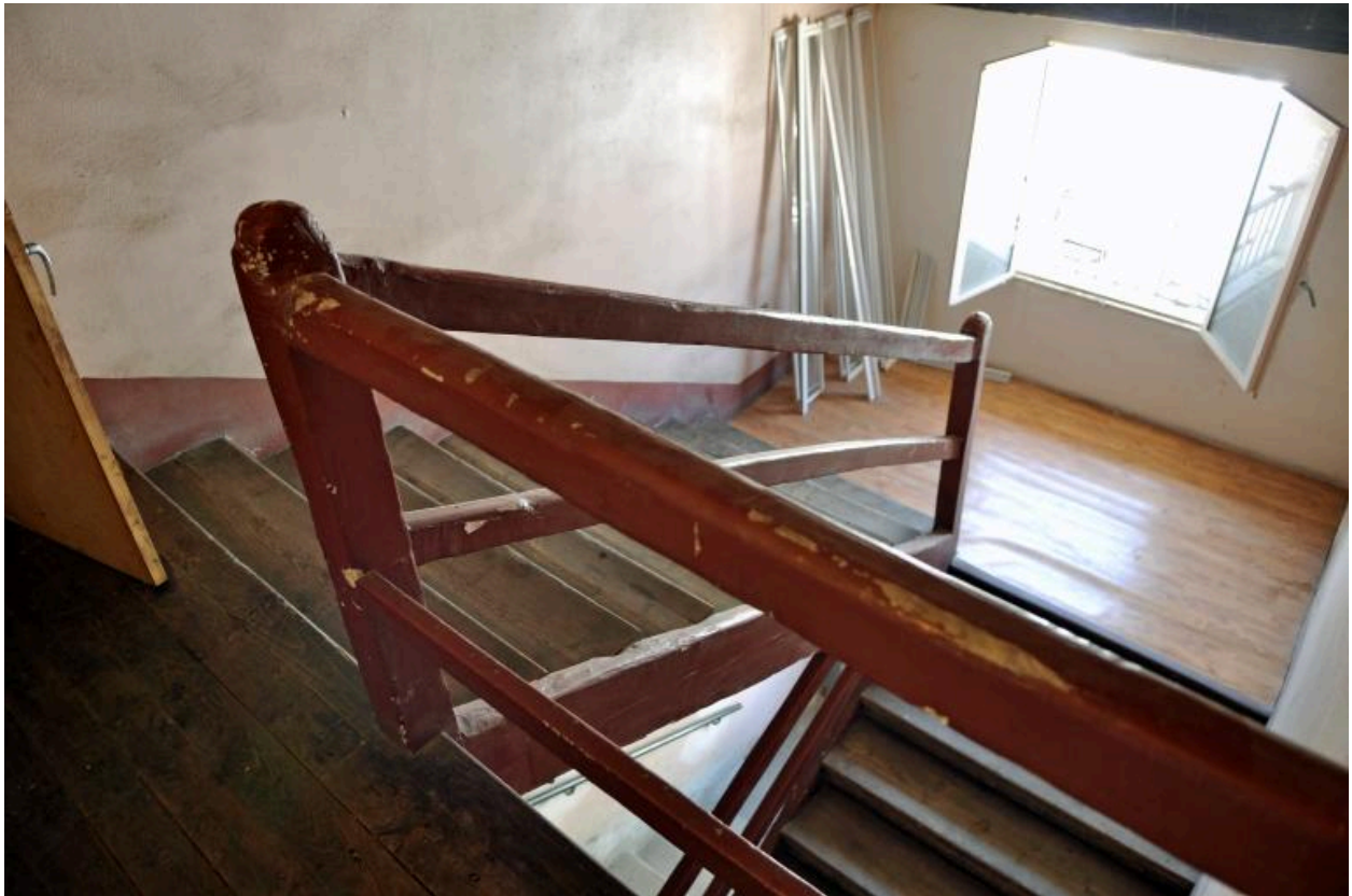
Vue de l'escalier, dernière révolution en bois
