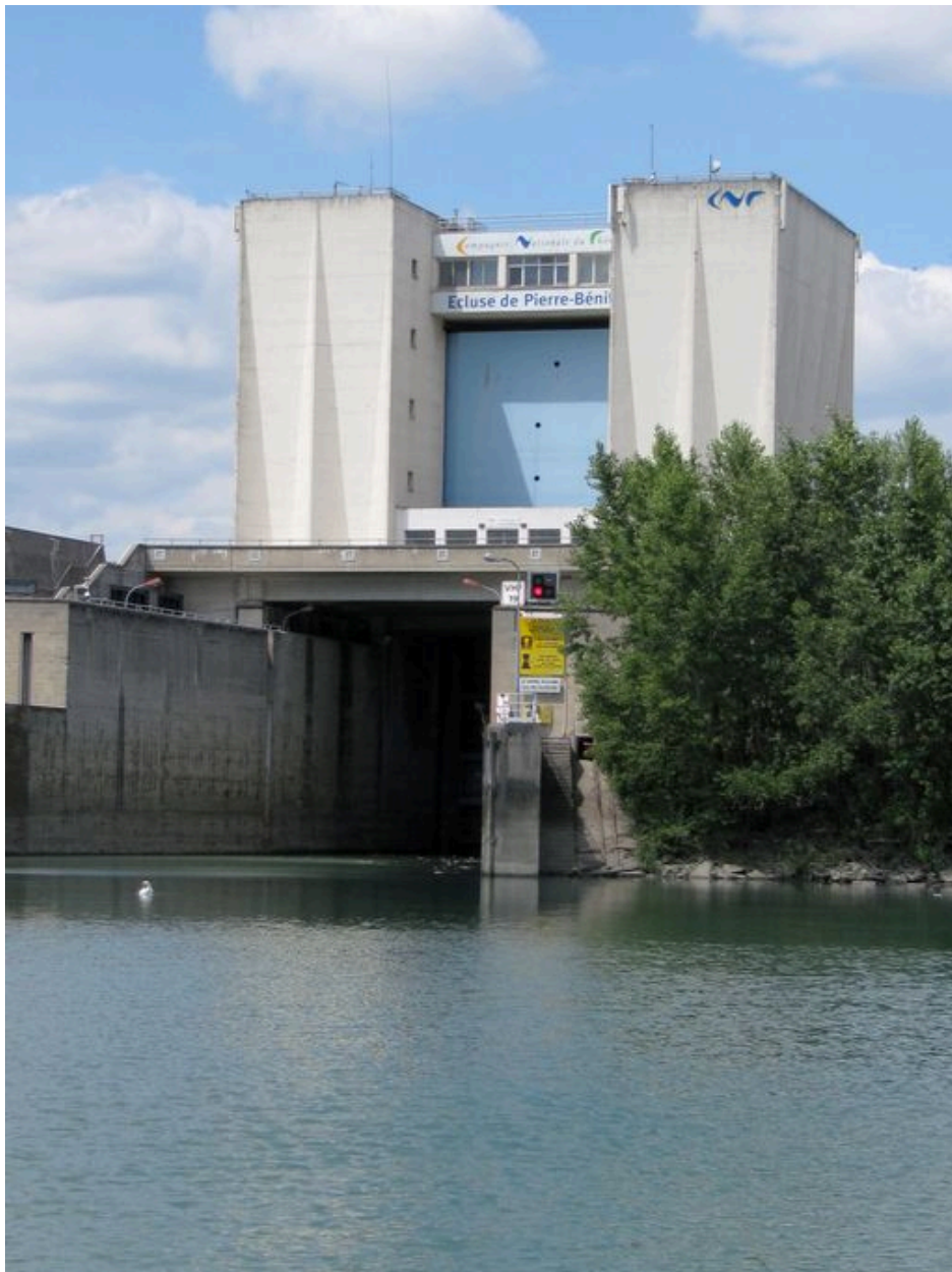
Vue de l'écluse, face aval (depuis la rive gauche)
