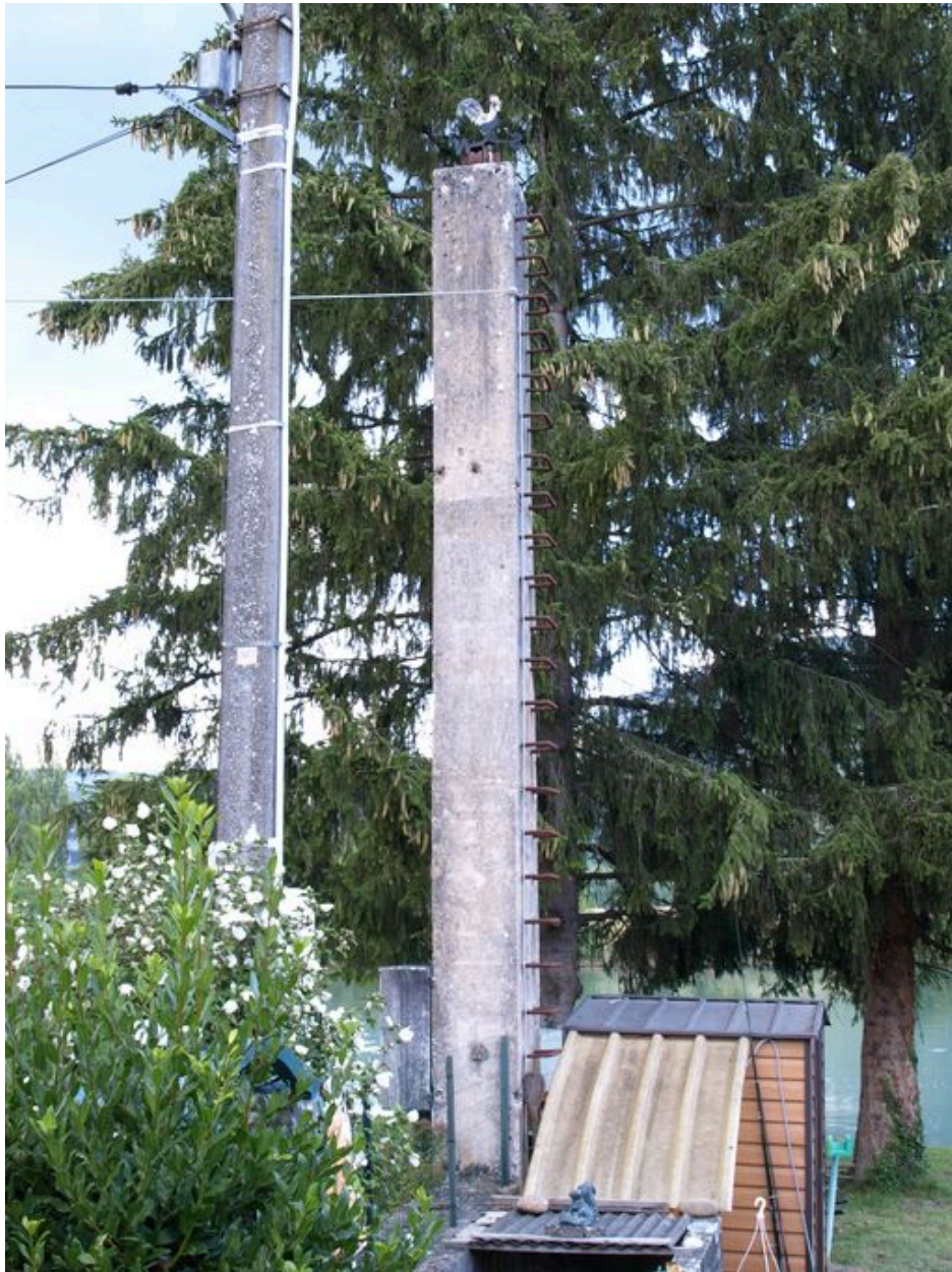
Pile, vue générale (face comportant l'escalier)
