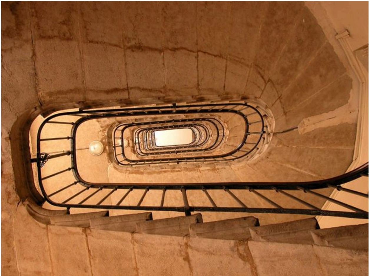
Vue de l'escalier en contre-plongée
