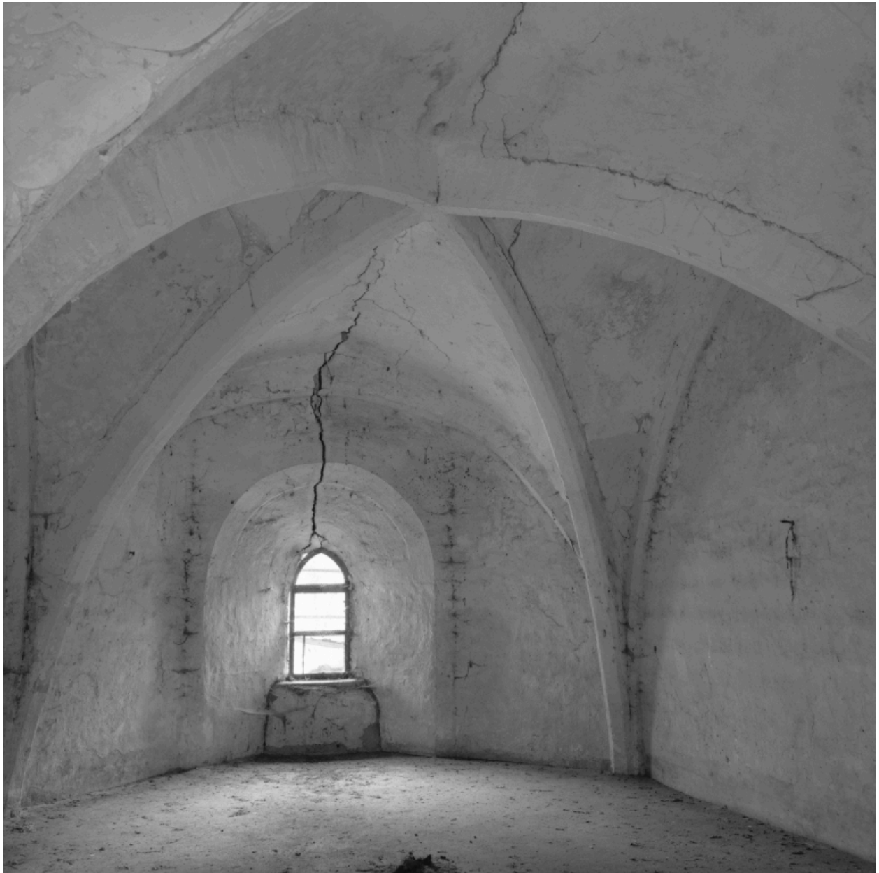
Vue d'ensemble intérieure de l'absidiole sud.
