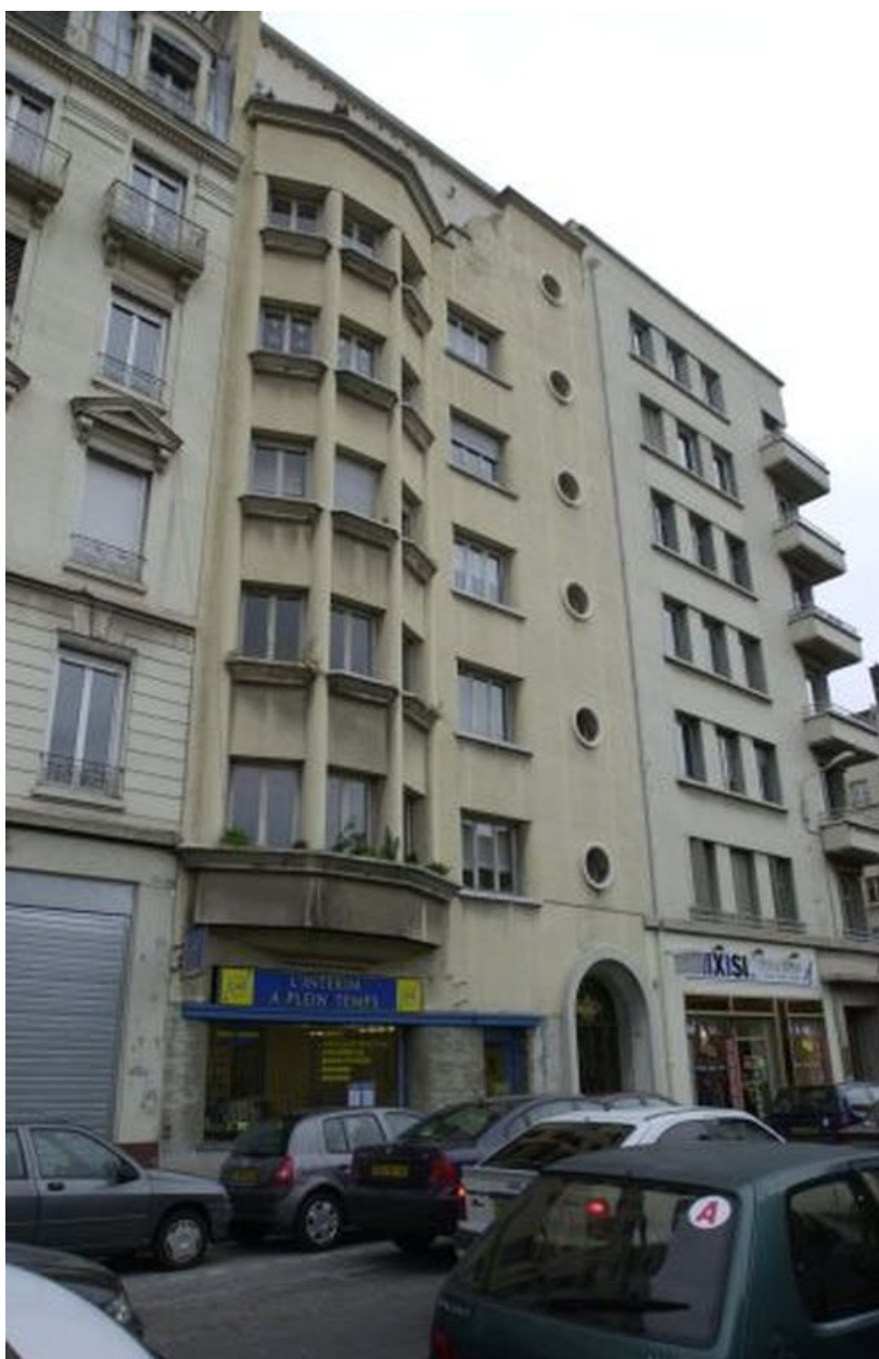
Vue générale de l'élévation
