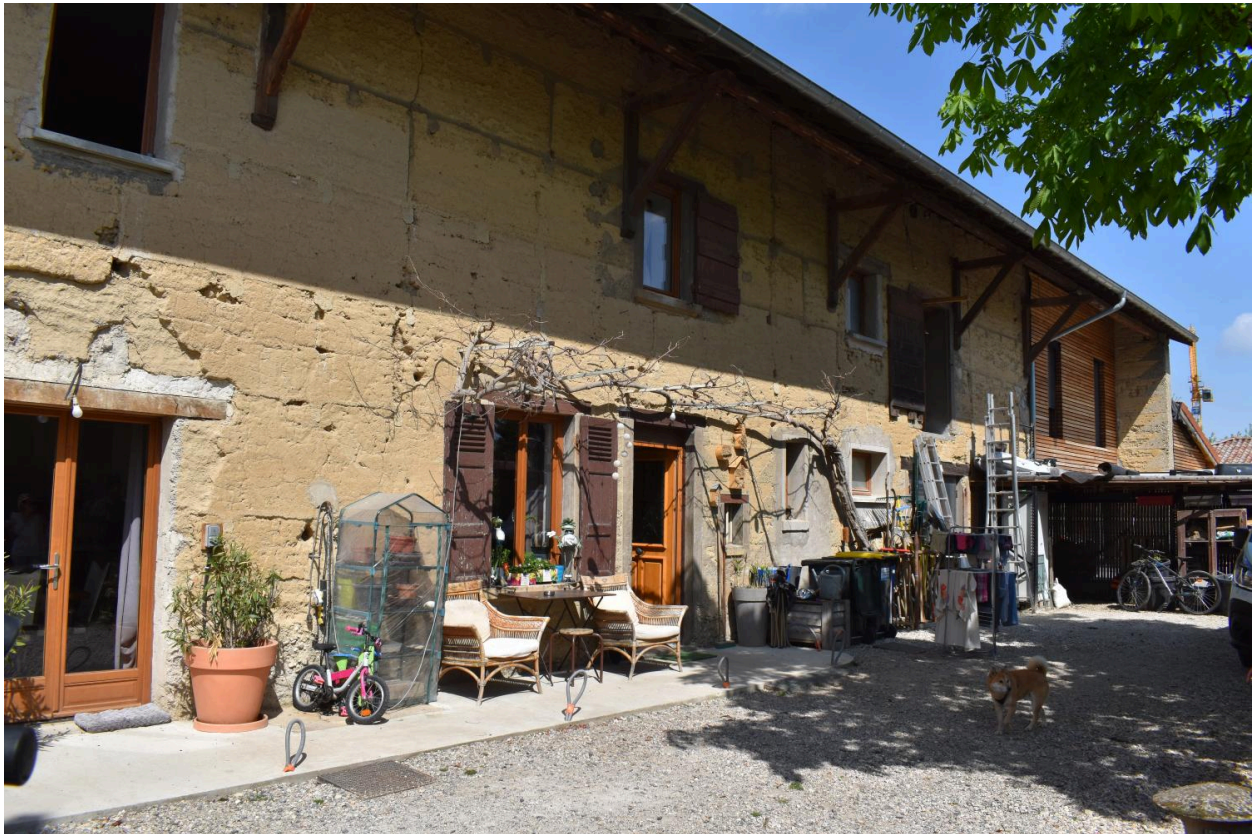
Façade principale, sur cour
