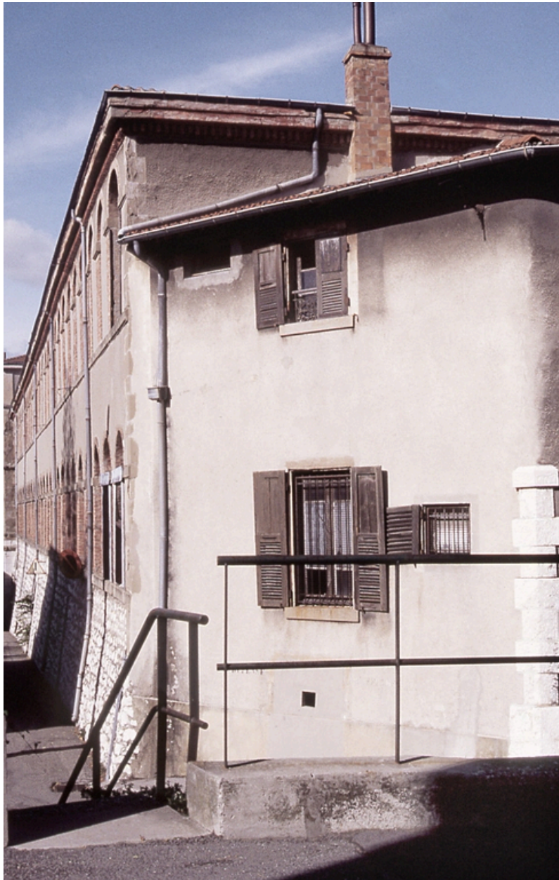
Bâtiment d'angle du chemin de Chony, vue est
