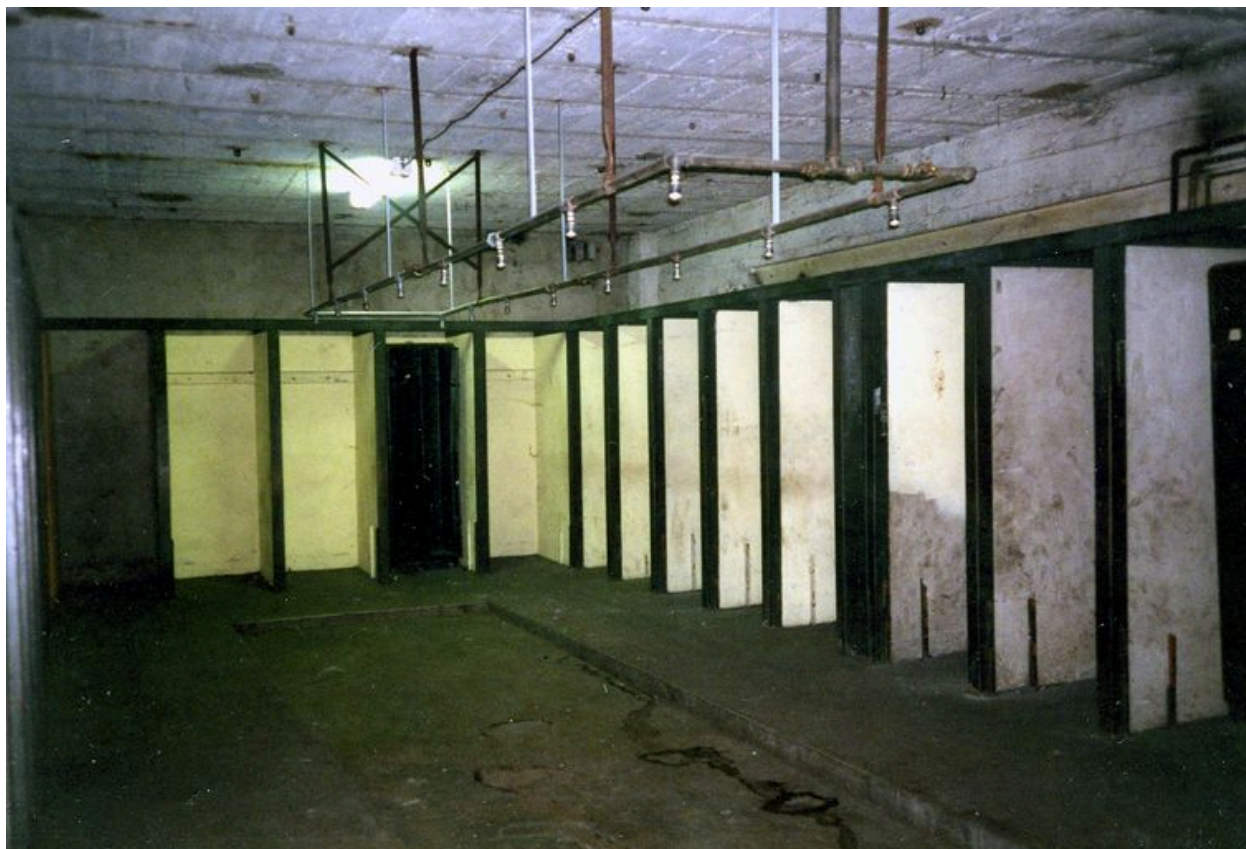
Anciens sanitaires avant leur démolition, 1995
