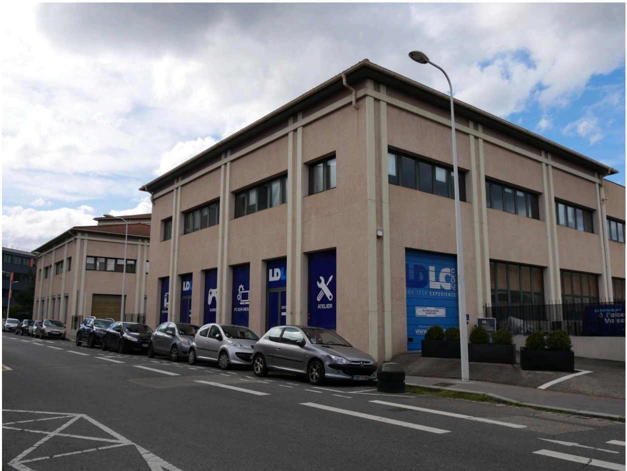
Vue d'ensemble de l'usine Poizat
