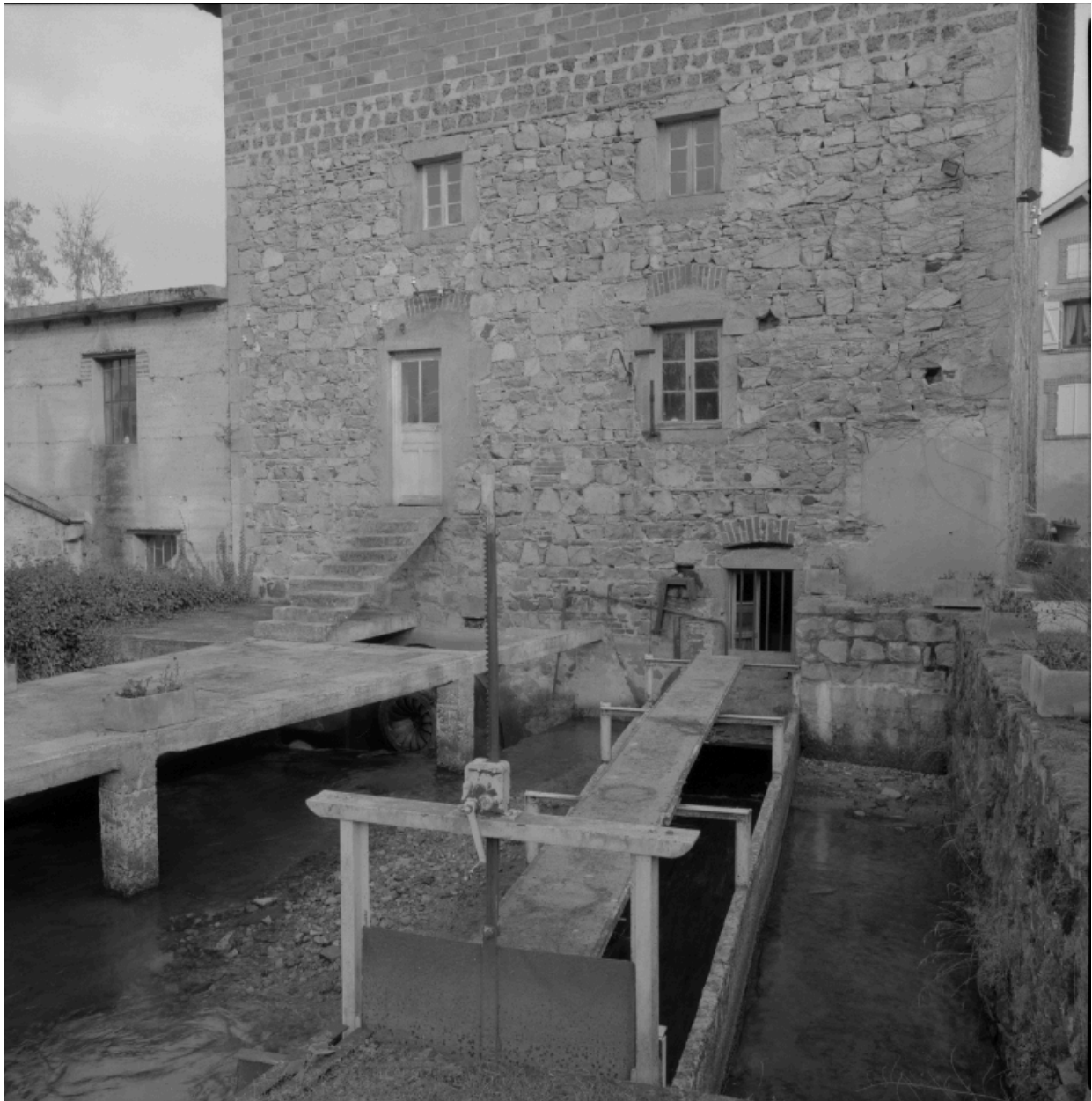
Façade latérale gauche du moulin, détail du bief et de la circulation de l'eau.
