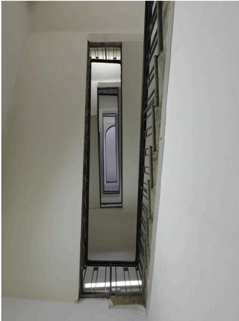
Escalier E : cage vue depuis le bas
