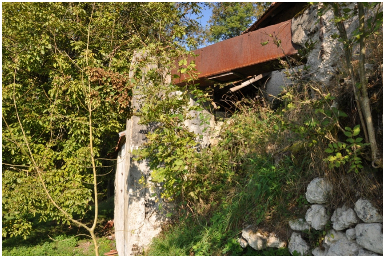
Détail de la conduite forcée terminant le canal d'aménage
