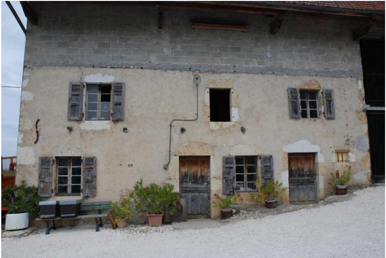
Vue d'ensemble de la façade principale orientée au sud.
