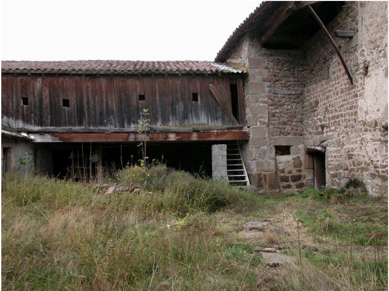
Vue de la grange-étable et du passage couvert.
