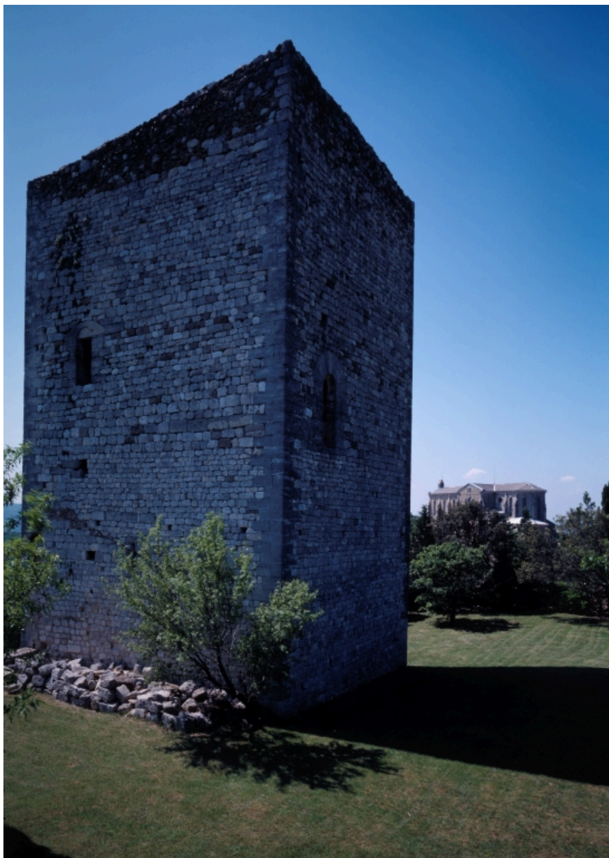
Le donjon sud-ouest, vue prise du nord-est.
