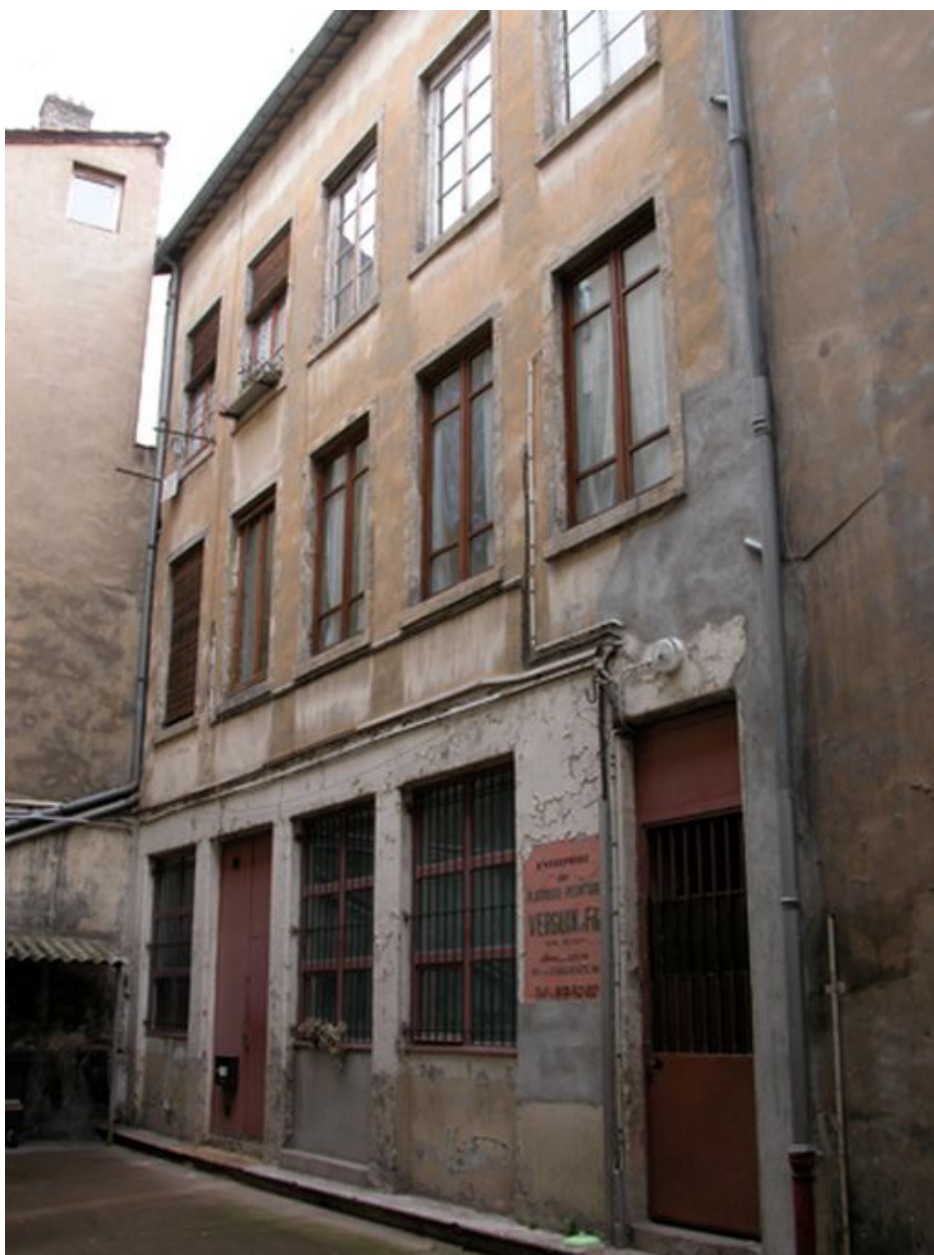
Elévation sur cour
