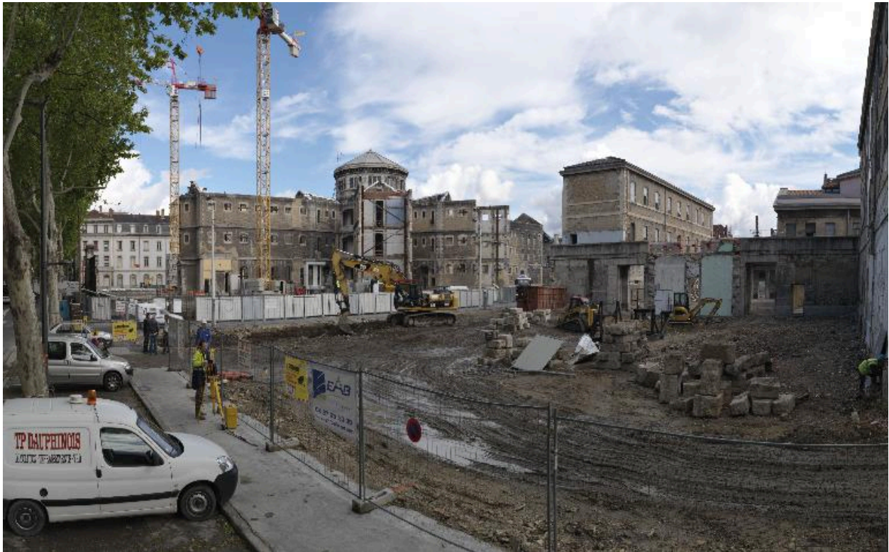
Etat en juin 2013 : vue d'ensemble depuis le cours Suchet
