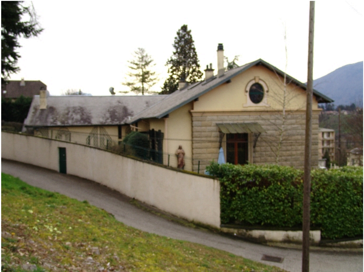
Vue depuis le nord
