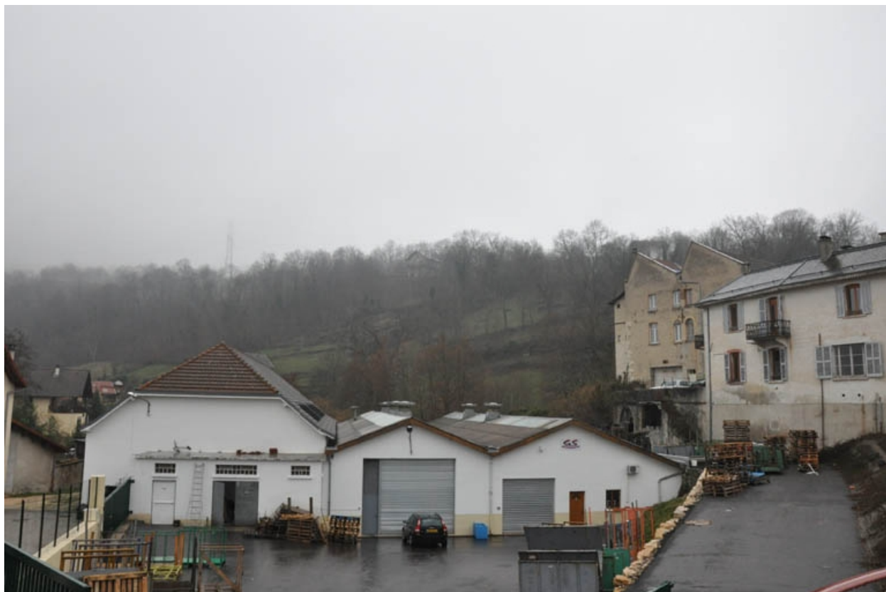
Vue de la partie ouest de l'ancienne usine de tulles occupé par l'entreprise GS
