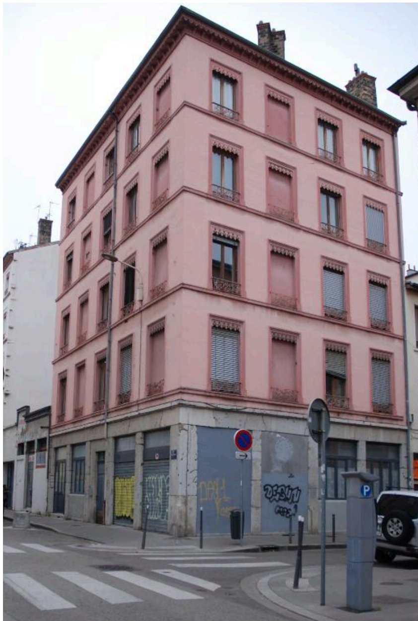
Vue générale, depuis le nord
