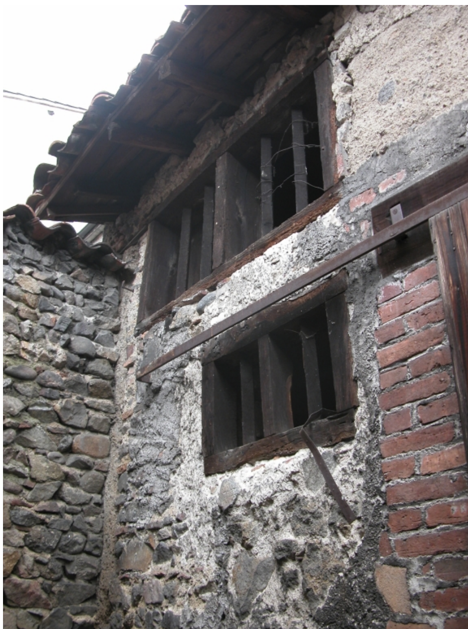
Îlot 2. Saint-Jean (rue) 28, 30. Traversière entre les deux maisons, détail des baies du premier étage de la parcelle 684.
