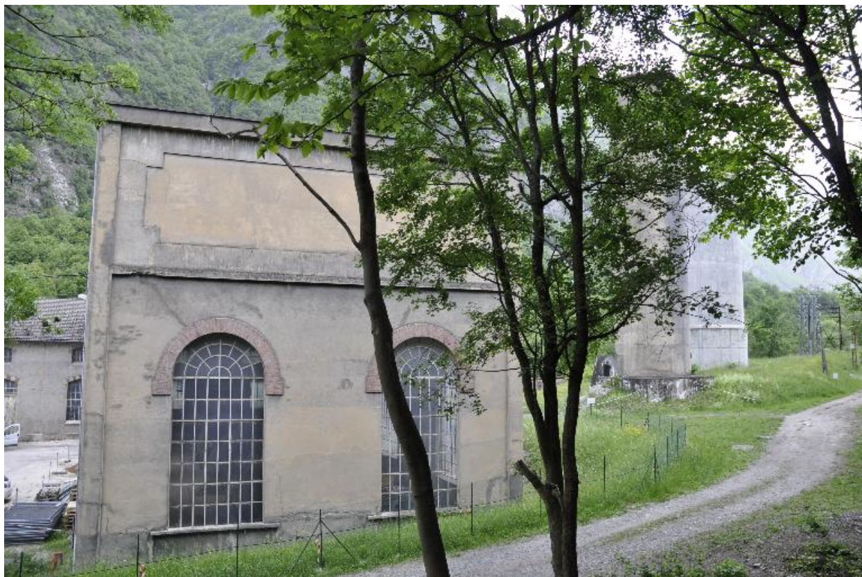
Vue du mur pignon de la centrale
