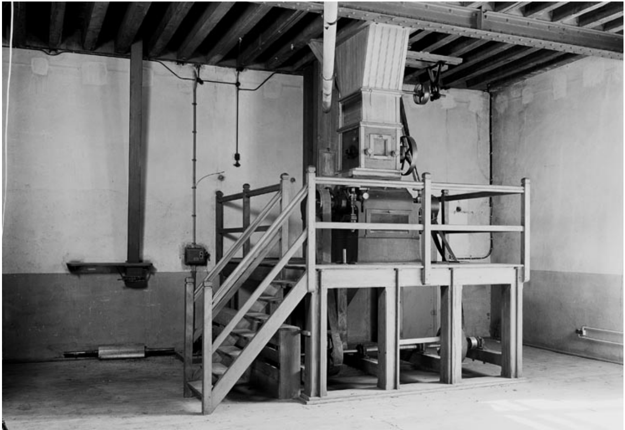
Moulin broyeur dans l'atelier ouest
