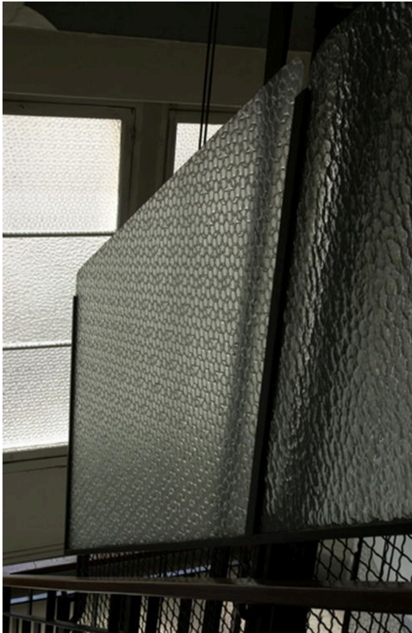
Parois de sécurité vitrées au-dessus du garde-corps de l'escalier
