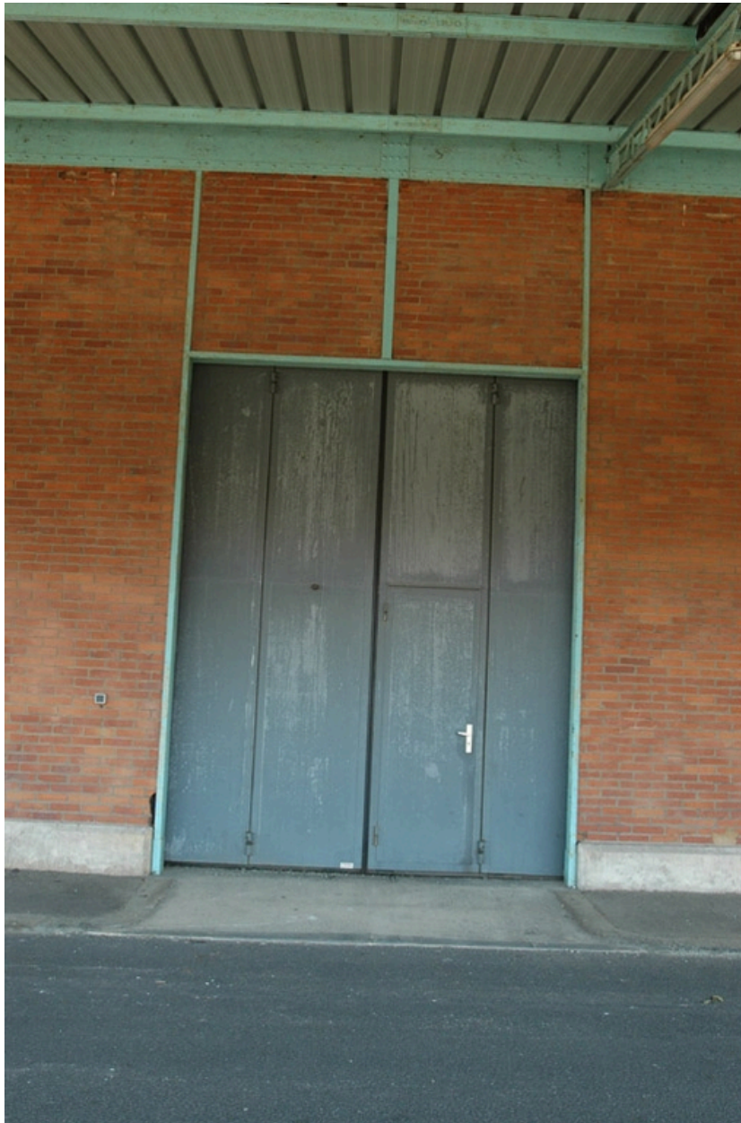
Détail porte métallique
