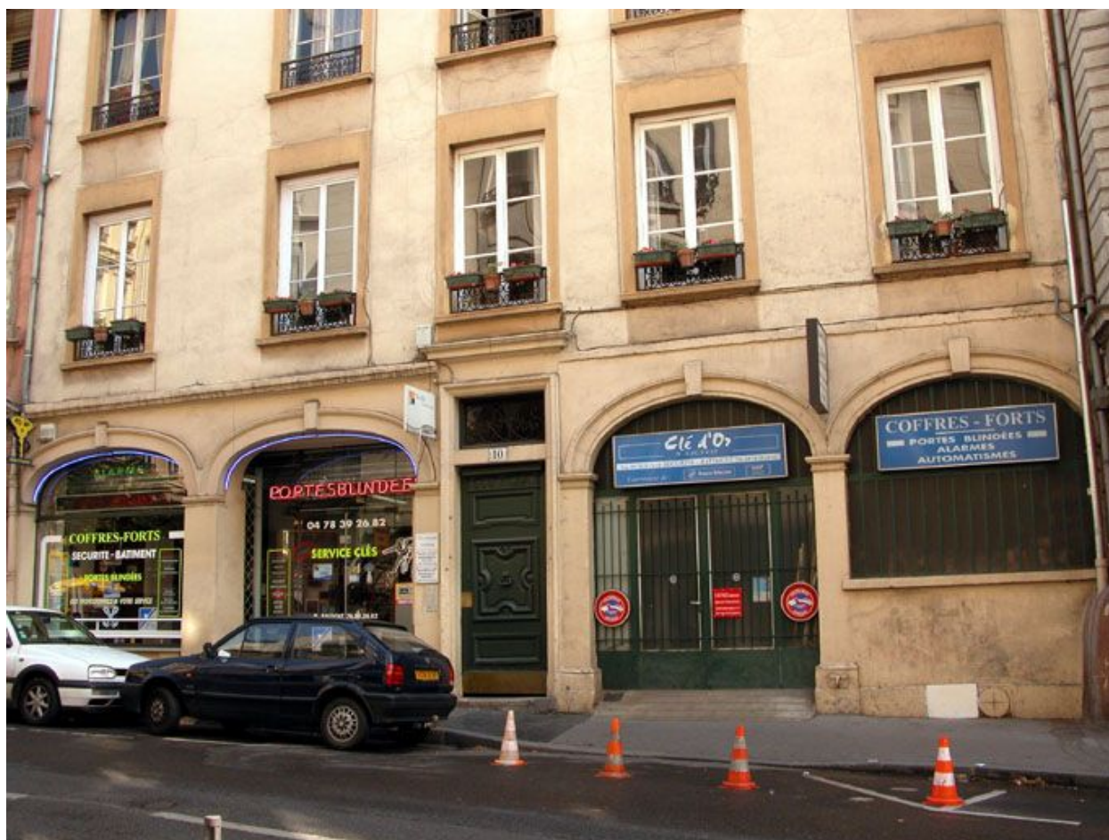
Façade sur rue, rez-de-chaussée
