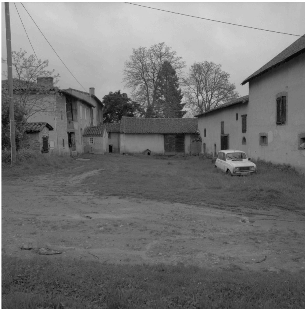
Vue d'ensemble de la basse cour, depuis le nord.
