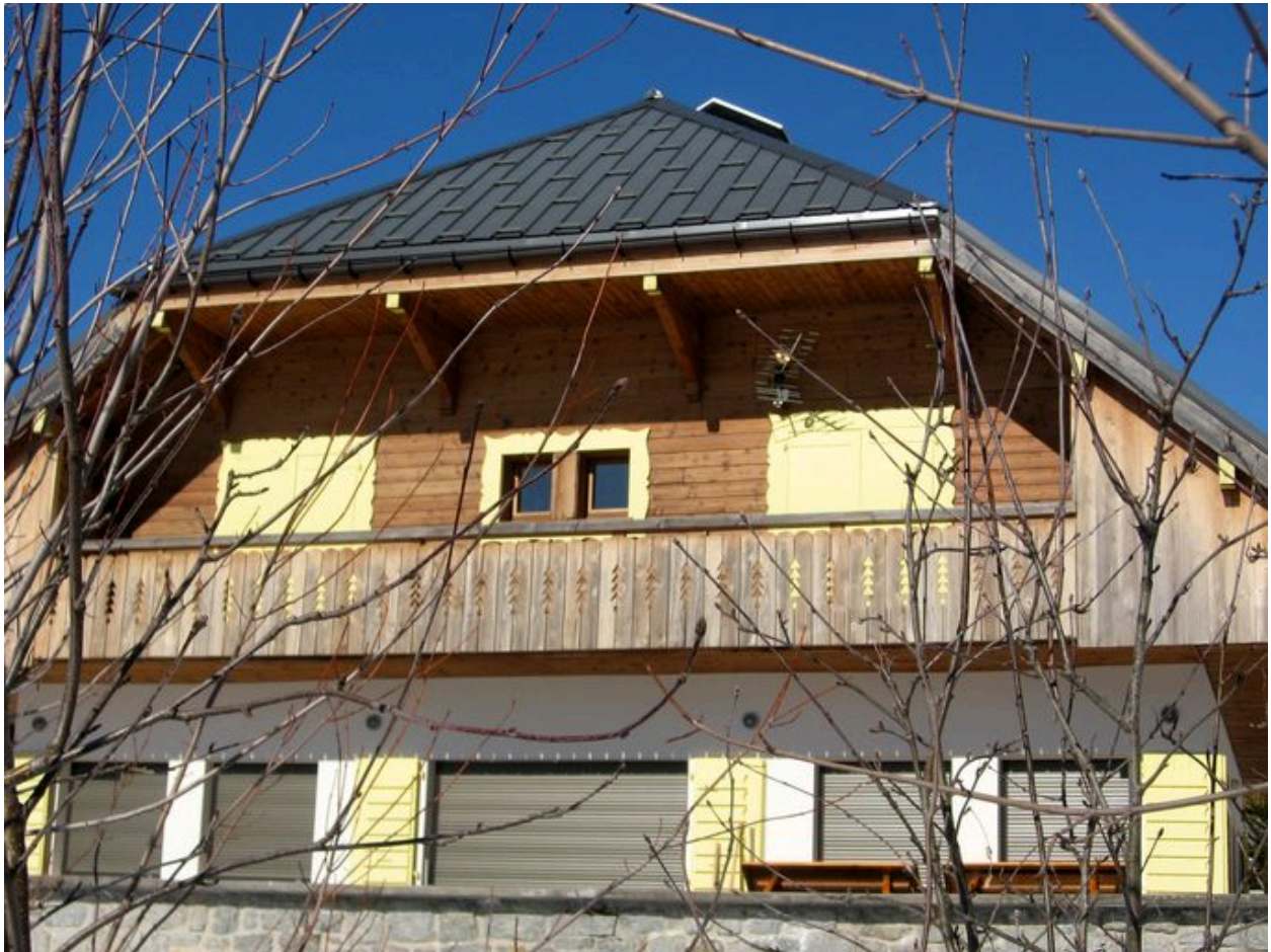
Façade sud. Détail de la loggia au niveau de l'étage de comble
