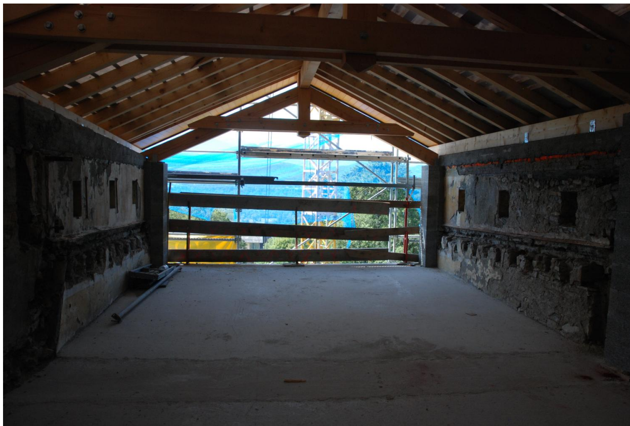
Vue intérieure du 3e étage : pièce sud, vue depuis le sud.
