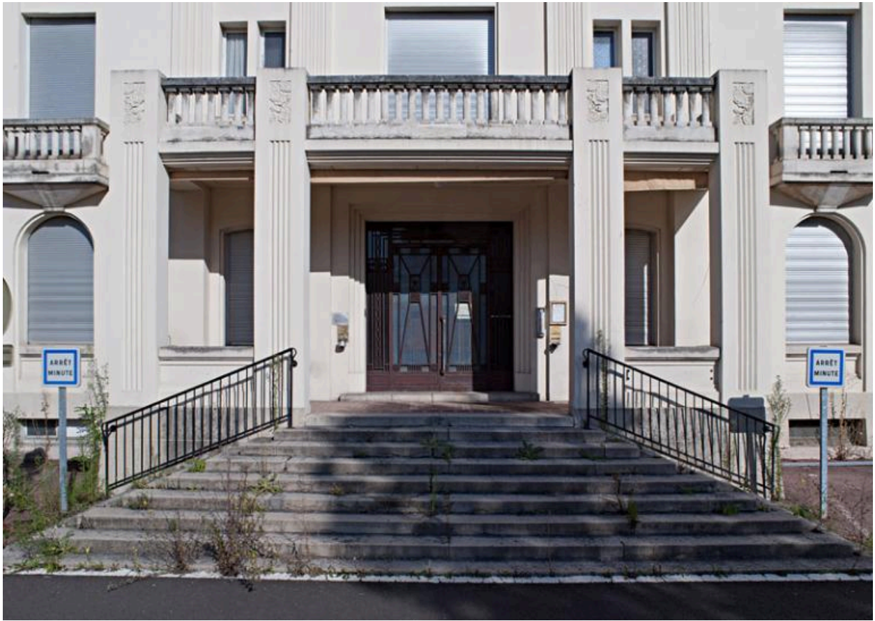
Hôtel-Dieu de Clermont-Ferrand. La polyclinique, façade principale, perron et porche de l'entrée principale.
