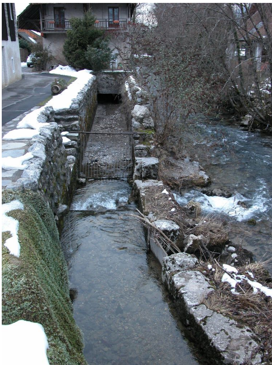
Vue du canal d'amenée d'eau de la scierie.
