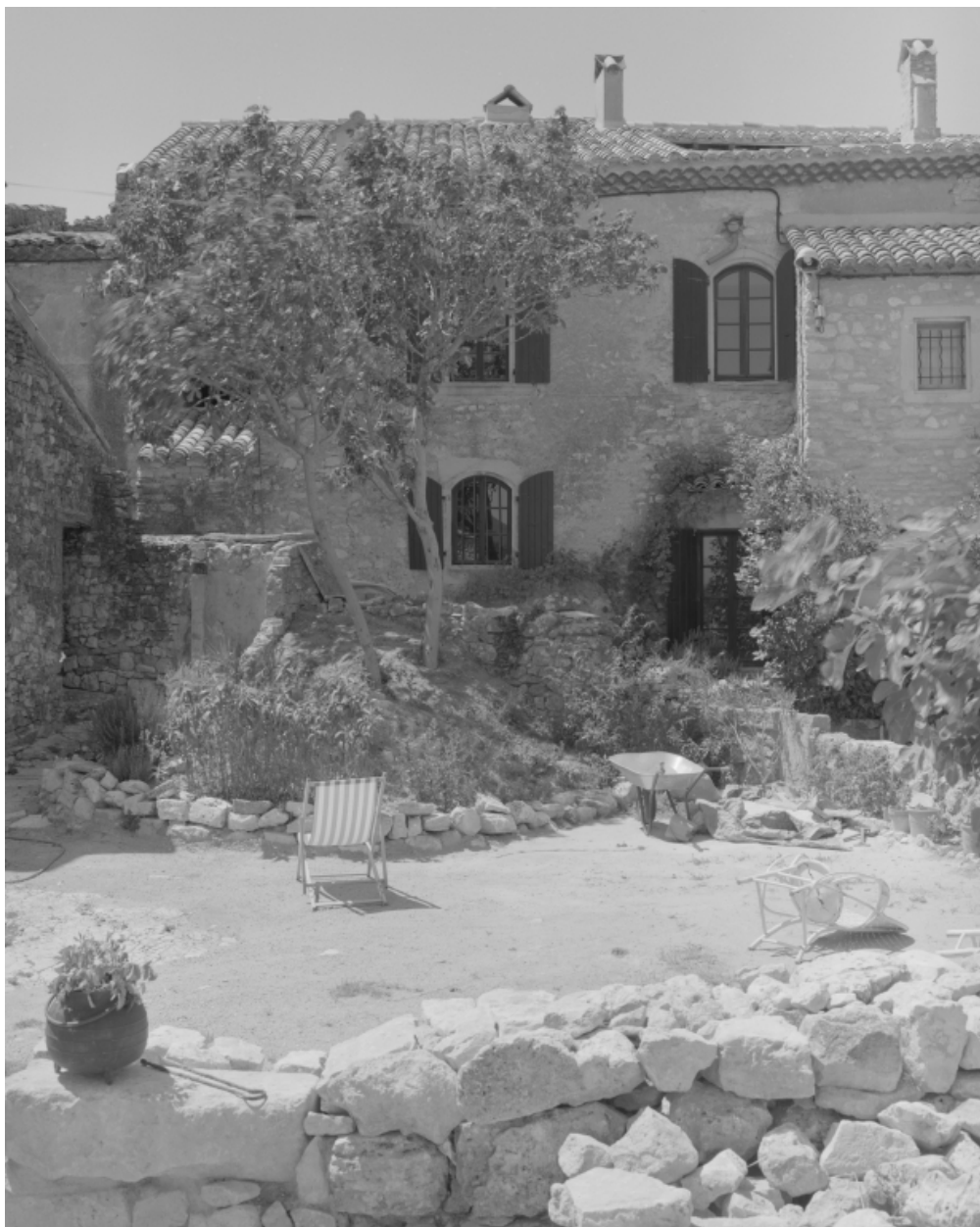
Hameau de Bayonne. Élévation principale d'une maison (H1 9), à fenêtres segmentaires.
