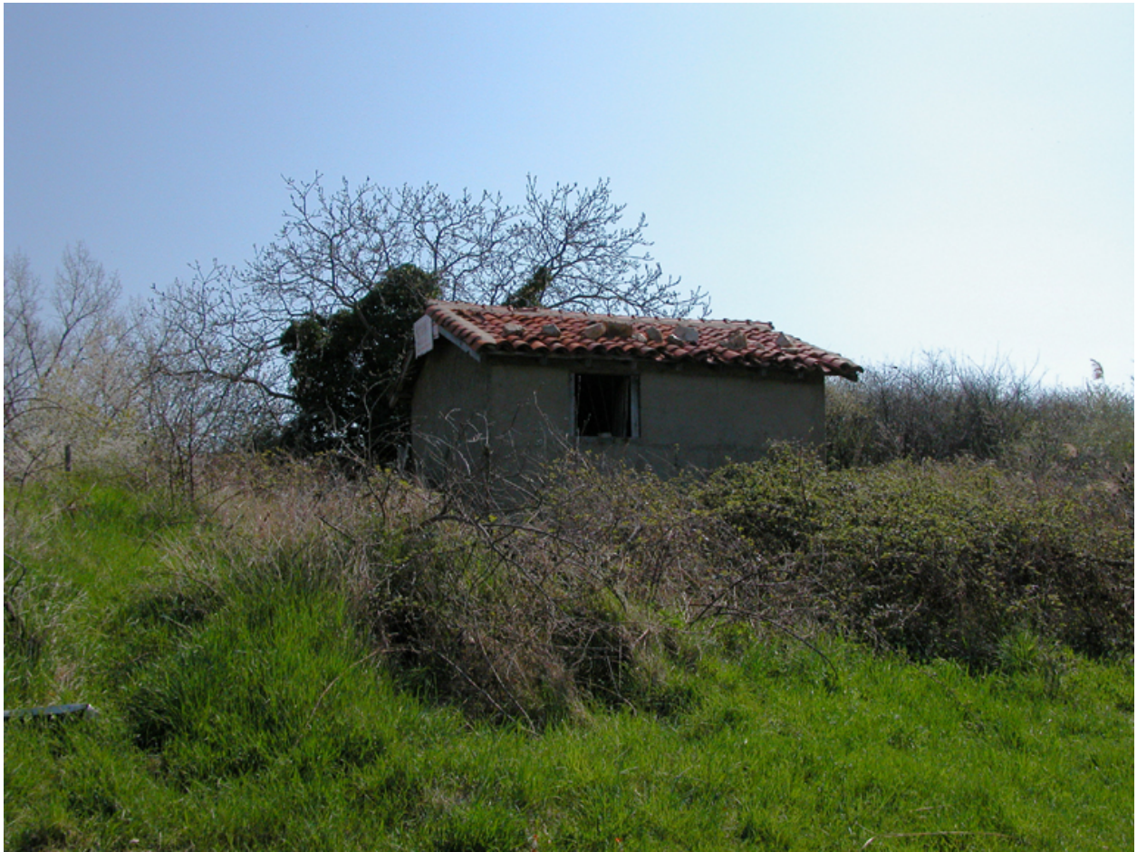
Vue du bâtiment 1984 B 44, construit sur la vanne de vidange de l'étang.
