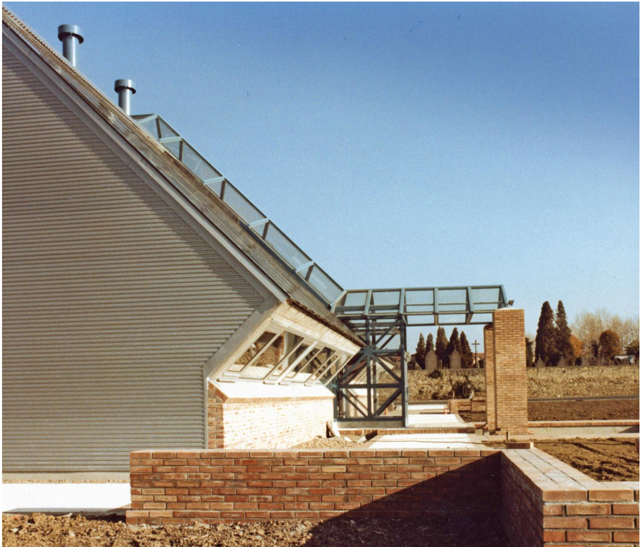
Billom, subdivision de la DDE, le corps de bâtiment sud vu du nord-ouest, état initial, 1983, archives privées J.-P. Reuillard.
