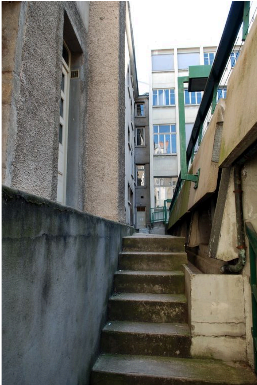
Belle Cour, accès menant au garage souterrain.
