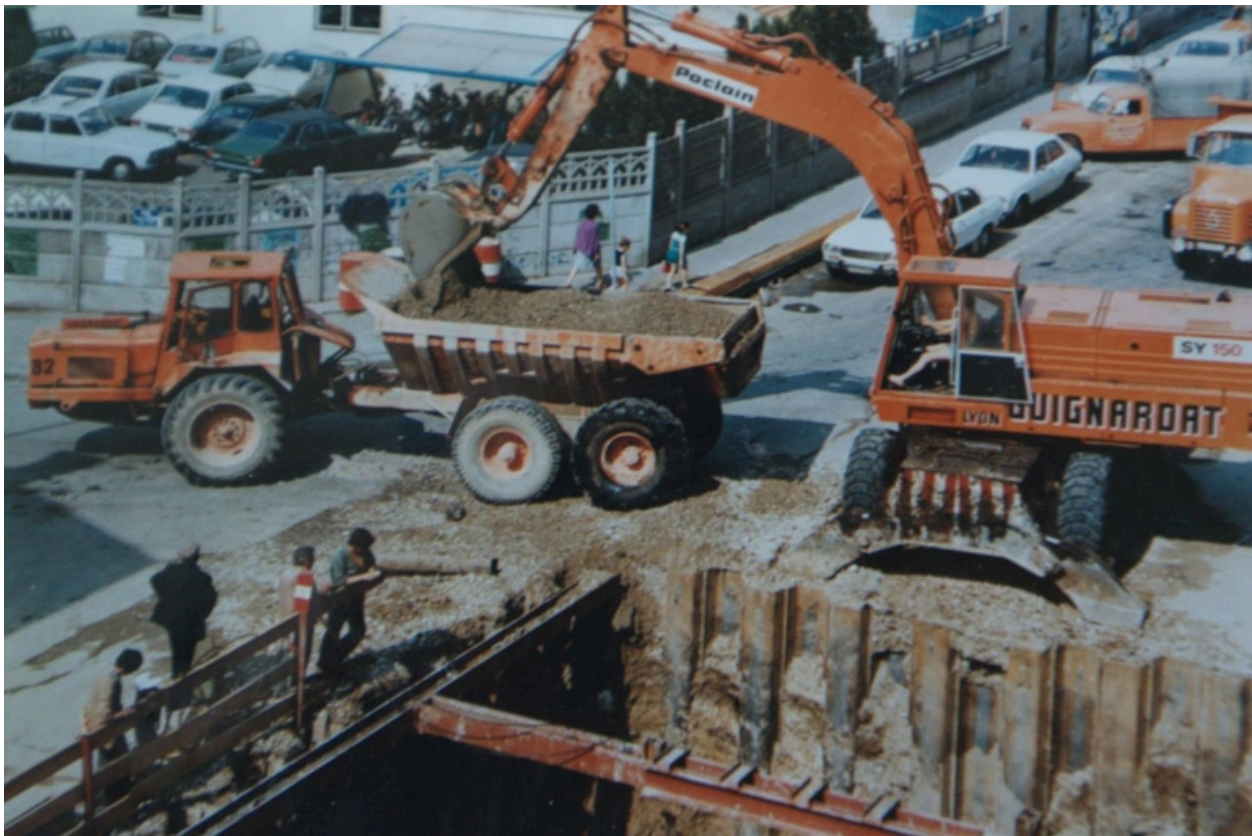
Chantier Guignardat : métro de Lyon, ligne A place Bellecour (vers 1970)
