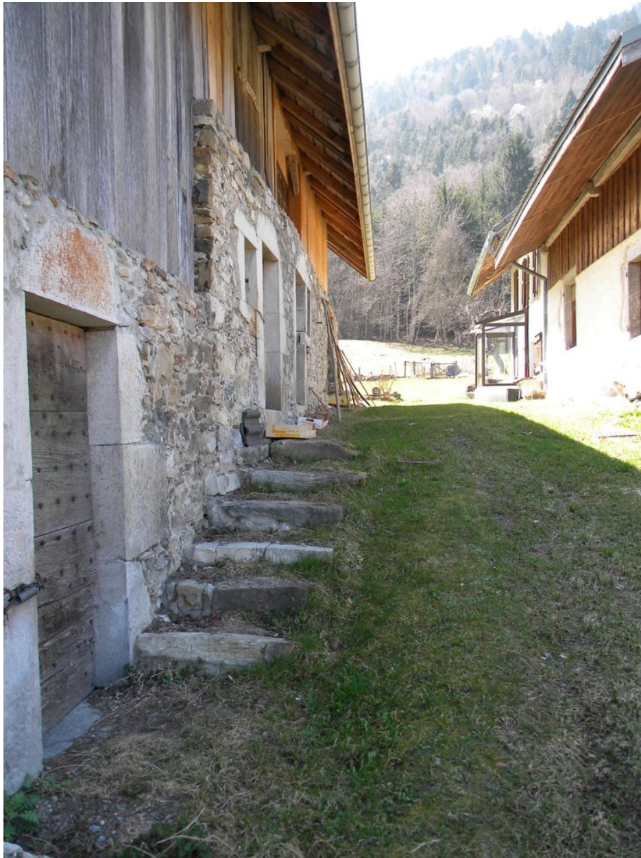
Détail de la montée d'escalier dans le talus le long du mur gouttereau.
