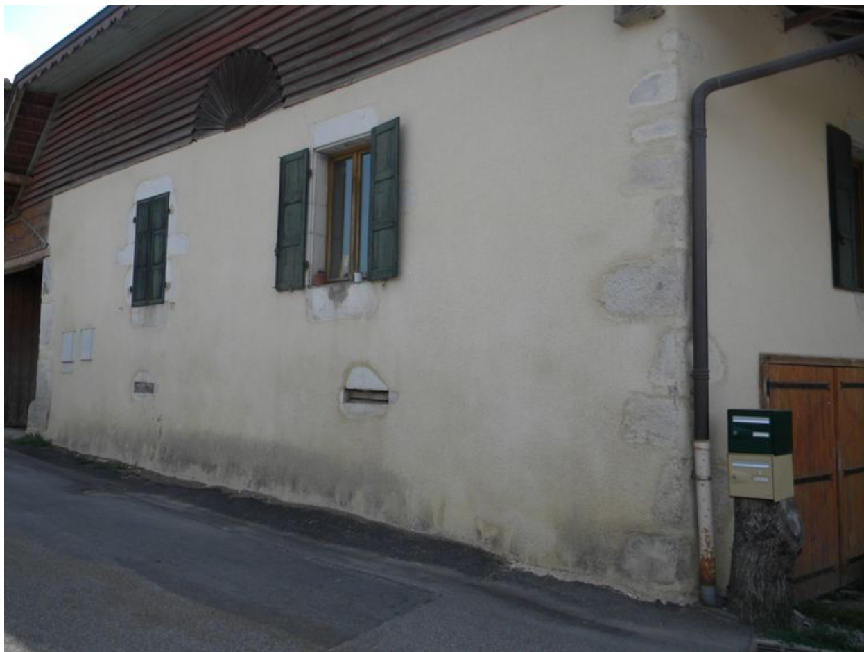
Vue du pignon est.
